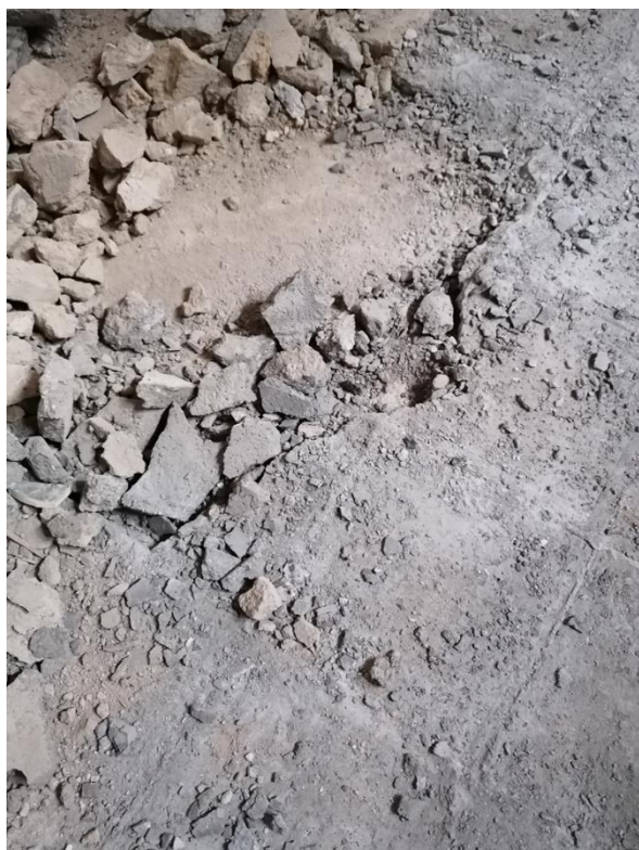
Stav podkladu po skrývce dlažby
