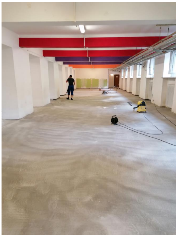
Stav podlahy po pokládce nivelační vrstvy
