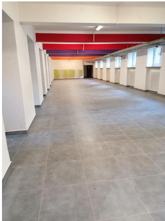
Stav po položení dlažby před konečnou výmalbou
